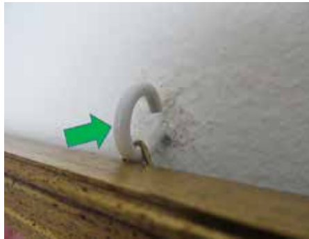
Fig. 3 - Quadro “sicuro”, fissato con un gancio chiuso.
