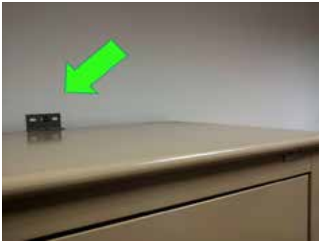
Fig. 2 - Mobile fissato alla parete con un gancio.
