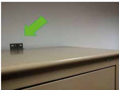
Fig. 2 - Mobile fissato alla parete con un gancio.
